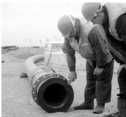
Фото 1.4 Разъемное фланцевое соединение ПЭ труб
